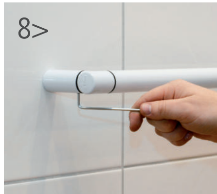
Inbus-schroefdraadstiften aandraaien
