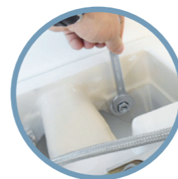
KERAMIEK VASTSCHROEVEN
