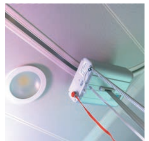
Volledige inbouw rail door middel van kunststof profiel.
